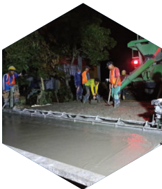
NIGHT CONCRETE POUR
